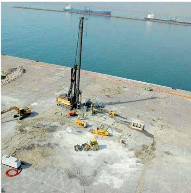
Panel de prueba de Inyección de Compactación (IC).
